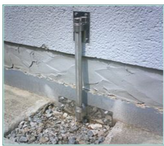
外部取付けの ホールダウンアンカー
