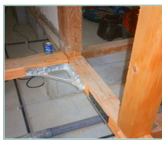
土台に取付けた 火打ち金物
