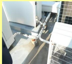
工事前：全長の半分近い断熱材が劣化しています。
