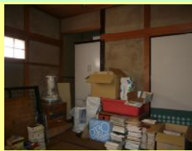
工事前: 書庫+収納から客間に変身させます。
